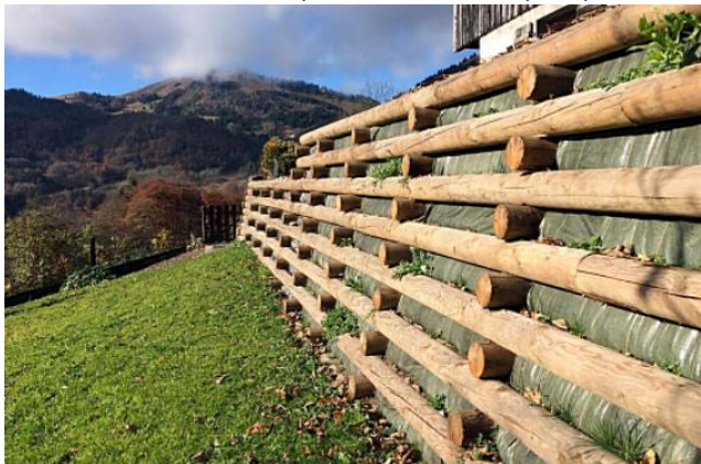
Gabions en bois en zone agricole, une alternative qui s'accorde assez bien avec le paysage naturel. Sces : Chambre d'Agriculture de Savoie.
