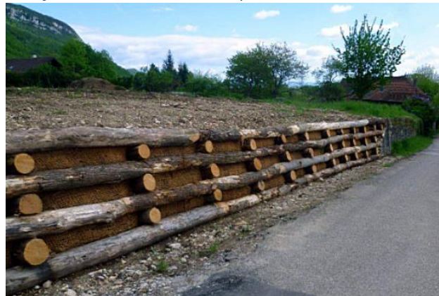
Gabions en bois en zone agricole, une alternative qui s'accorde assez bien avec le paysage naturel. Sces : Chambre d'Agriculture de Savoie.
