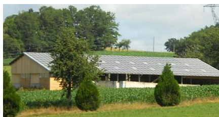
Exemple d'application du principe « 2/3 – 1/3 » sur un bâtiment agricole photovoltaïque récent.
